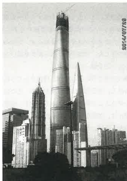
「建設中の上海センタービル (632m)」
